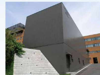
水道水をためる受水槽（海拔約23m） 通常の病院業務に必要な水量の3日分
